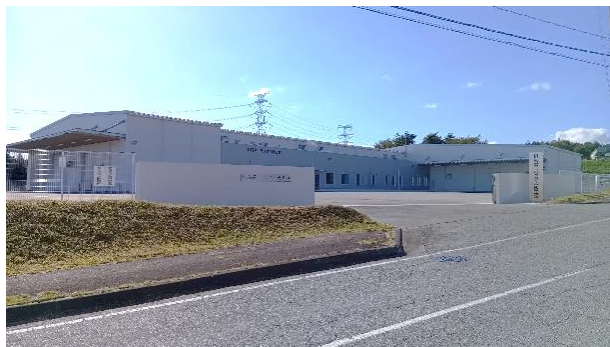
(株)相馬屋／パックごはん工場 (檜葉南工業団地内)
