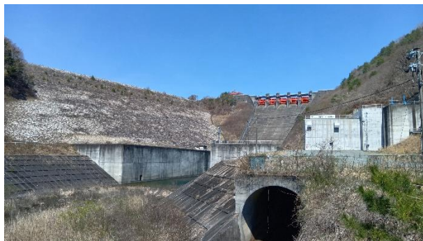
請戸川水力発電所建設工事 (浪江町)
