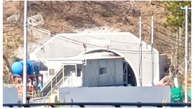
小野富岡線(仮称)五枚沢2号トンネル (川内村～富岡町)
